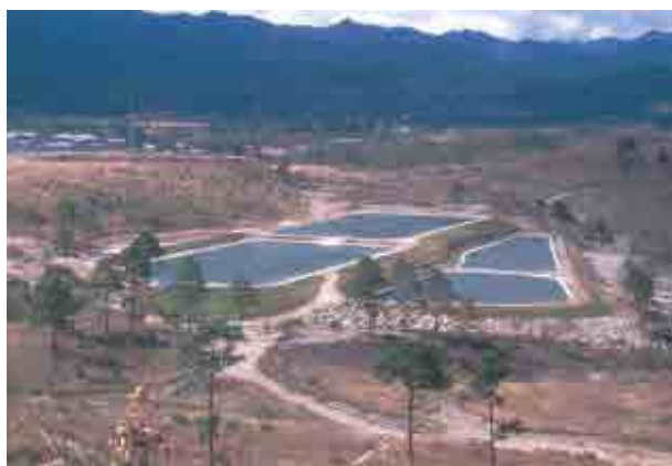
Foto 54. Planta de lagunas de estabilización de Honduras
