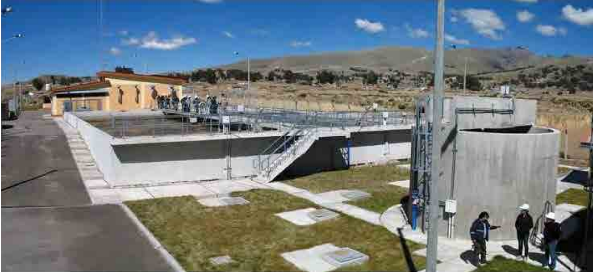
Foto 44. Planta de lodos activados de Yunguyo, Puno
