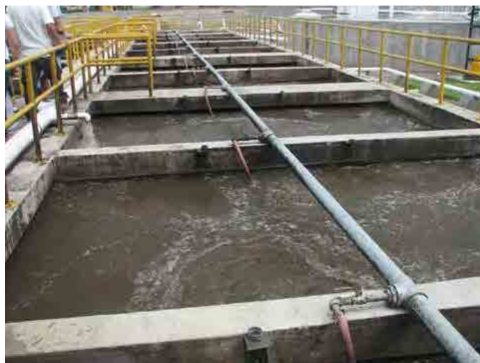
Foto 37. Planta de lodos activados de Yunguyo
