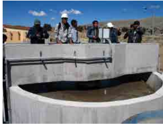
Foto 56. Supervisión diaria de la PTAR
