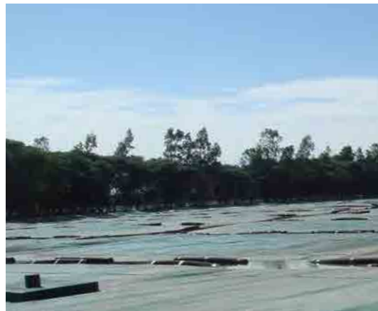
Foto 11. Laguna anaeróbica cubierta
