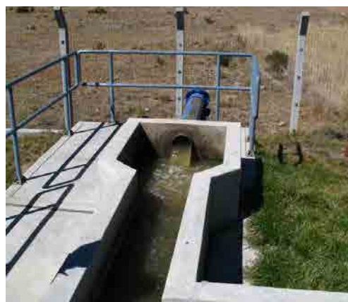
Foto 71. Canal de ingreso con aliviadero
