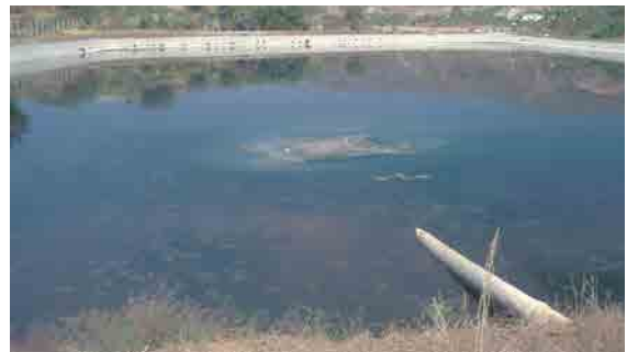
Foto 46. Entrada de agua al centro de la laguna
