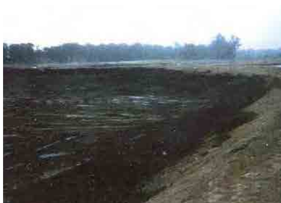
Foto 69. Reparación de diques en lagunas
